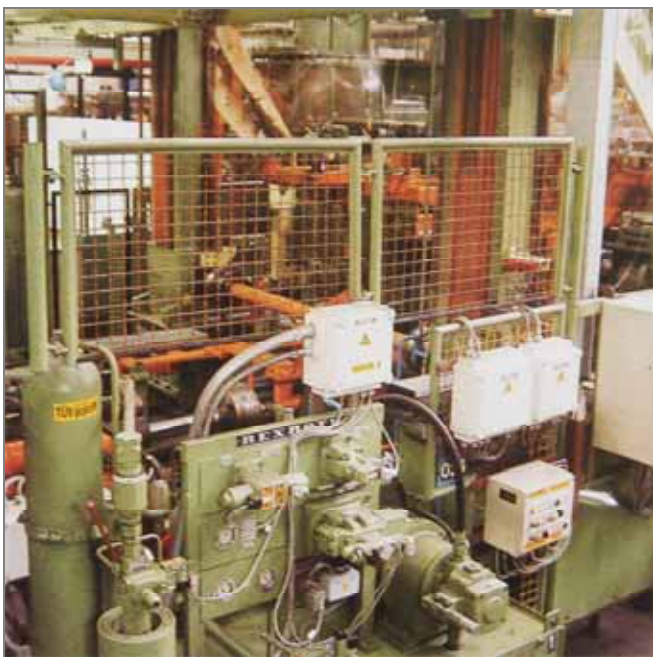
图 281. 左边的蓄能器单元提供高速运行所需的 460L/min 压力油，右侧的 V4 型叶片泵在液压缸不动作时向蓄能器充液。安装在阀板右侧的是比例方向阀 4 WRZ25。
